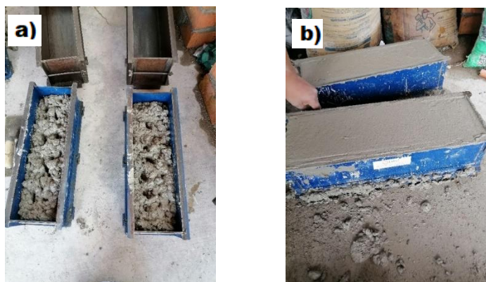
Figura 3.22. a) Varillado del concreto b) Enrazado del concreto.
