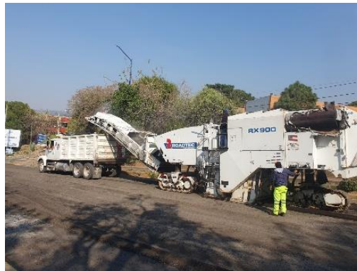
Figura 2.6.- Fresado de carpeta asfáltica. Fuente: elaboración propia.
