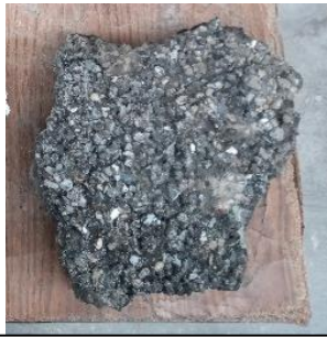
Figura 3.6.- Material de fresado de carpeta asfáltica. Fuente: elaboración propia.
