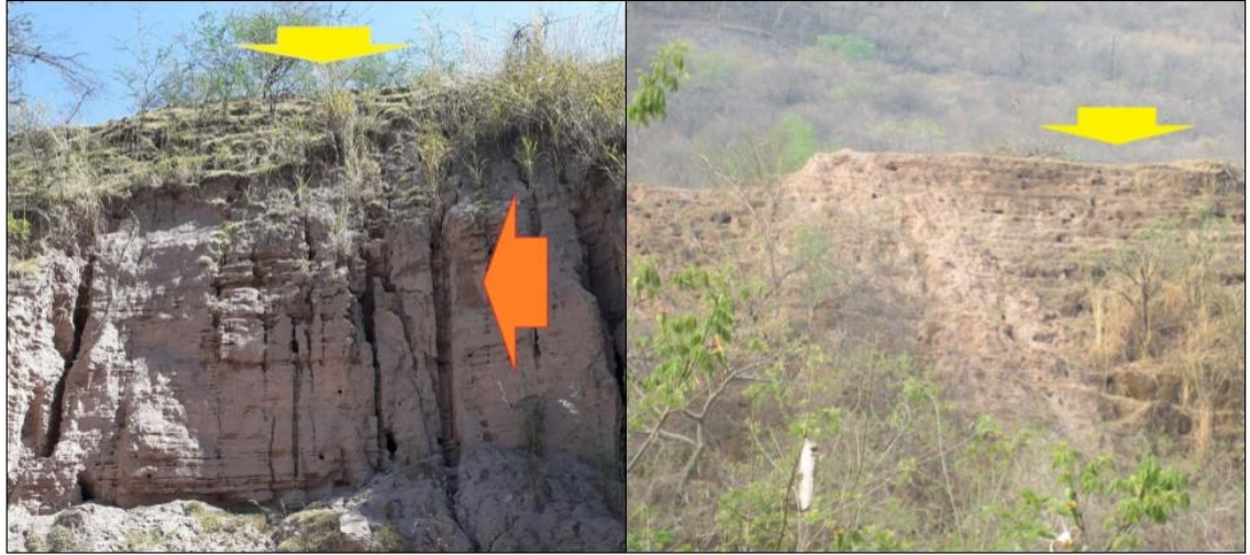
Figura 9. Vistas oblicuas de dos presas de jales. A) Las Presas; B) Los Molinos. Los bancos son zonas superficiales y planas (flecha amarilla), el talud presenta pendientes en las presas de jales (flecha roja). Fotos: R. Márquez-Huitzil (2022, 2017).
