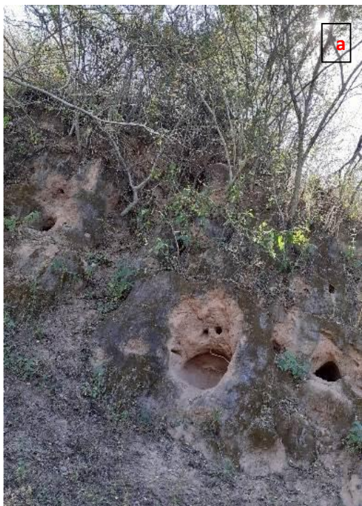
Figura D. Proceso de tunelamiento en las presas de jales. a. Tubificación (orificios pequeños que abren tubos) y tunelamiento (orificios grandes que abren túneles) en el talud de Las Presas; b. Tunelamiento y colapso de túneles en el banco de Los Molinos (Fotos: Márquez-Huitzil, R., 2022).
