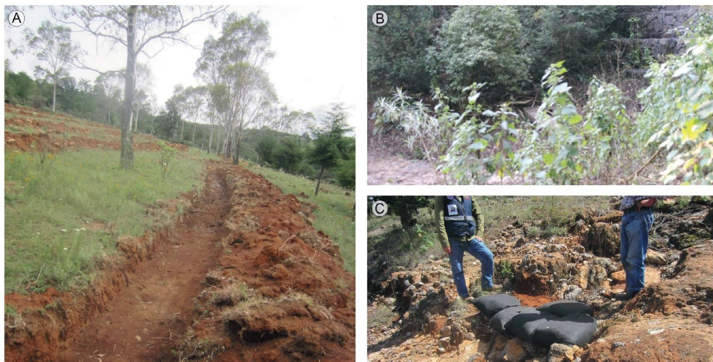
Figura 9: Estrategias para el control del desplazamiento de materiales e infiltración. A. zanjas a contorno; B. presa de gavión; C. presa de geocostales (Fotos: R. Márquez-Huitzil, 2021).
