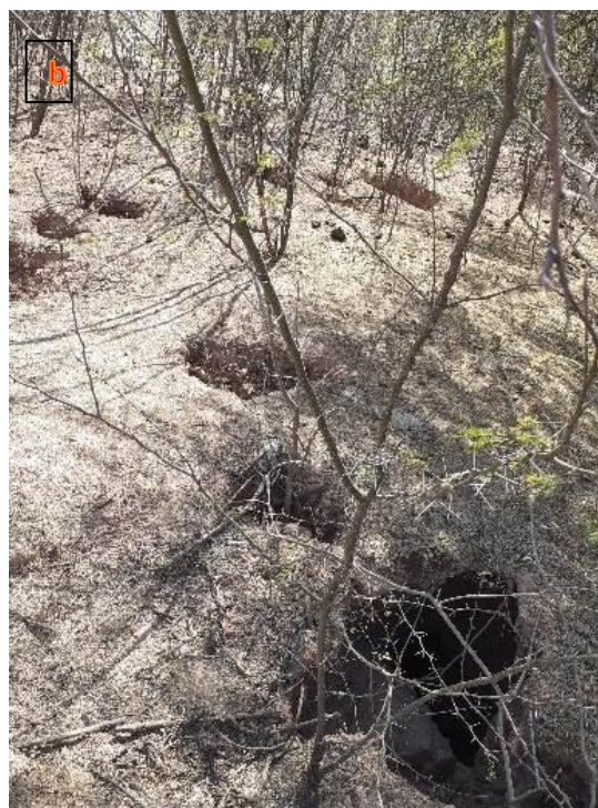
Figura D. Proceso de tunelamiento en las presas de jales. a. Tubificación (orificios pequeños que abren tubos) y tunelamiento (orificios grandes que abren túneles) en el talud de Las Presas; b. Tunelamiento y colapso de túneles en el banco de Los Molinos (Fotos: Márquez-Huitzil, R., 2022).
