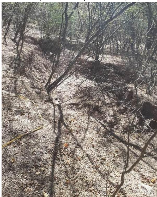
Figura D. Proceso de tunelamiento en las presas de jales. a. Tubificación (orificios pequeños que abren tubos) y tunelamiento (orificios grandes que abren túneles) en el talud de Las Presas; b. Tunelamiento y colapso de túneles en el banco de Los Molinos (Fotos: Márquez-Huitzil, R., 2022).
